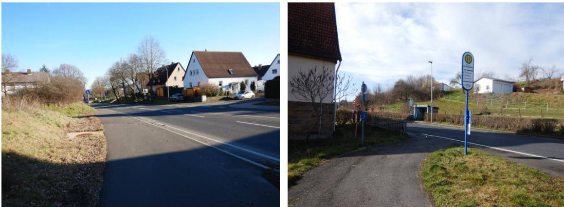
Abbildung 16: Fehlende Überführung vom Radweg auf die Fahrbahn am Ortseingang von Angenrod (Alsfeld) und am Ortseingang von Grebenau aus Wallersdorf kommend (Quelle: Eigene Aufnahmen)
